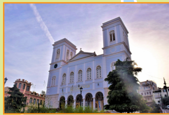
Αποκατάσταση Ιερού Ναού Παντάνασσας Πατρών
