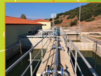
Κατασκευή Βιολογικού Καθαρισμού Καλαβρύτων
