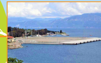
Ολοκλήρωση Λιμενικών Έργων και Κατασκευή Βασικών Έργων Επιδομής Νέου Λιμένα Αιγίου
