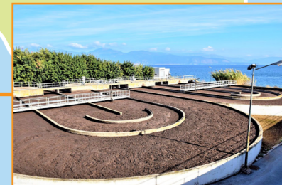
Κατασκευή Κεντρικών Αποχετευτικών Αγωγών παραλιακών Οικισμών από Δήμο Ερινεού έως Δήμο Αιγείρας
