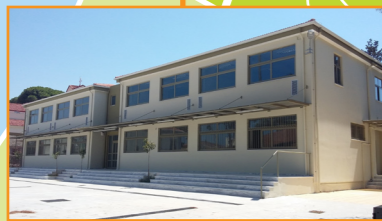
Ανέγερση Δημοτικού Σχολείου Λάππα
