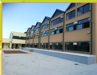
Ανέγερση Σχολικού Συγκροτήματος Νηπιαγωγείο, Δημοτικό, Γυμνάσιο και Λύκειο Ερυμάνθειας
