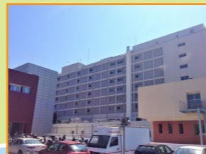
Αναβάθμιση Κεντρικού Κτιρίου Γενικού Νοσοκομείου Πατρών «Ο Άγιος Ανδρέας» και προμήθεια εγκατάσταση ιατρικού ξενοδοχειακού και λοιπού εξοπλισμού
